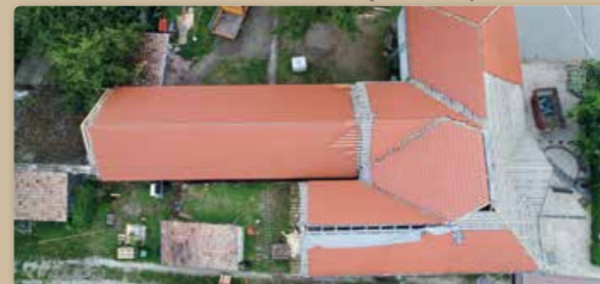
A Polgármesteri Hivatal tetőfelújítása jól halad, amint az elkészül, azután következnek a belső felújítás munkálatai.
