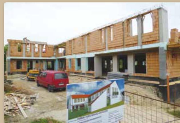
Az egészségház tetőterének szerkezetépítési munkálatai
