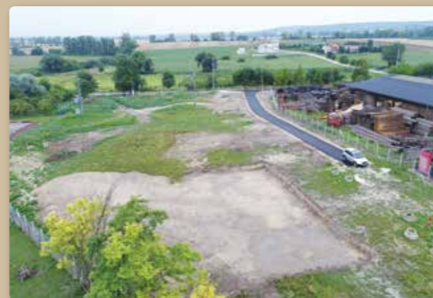
Az iparterületen elkezdődtek az önkormányzat csarnokának földmunkái
