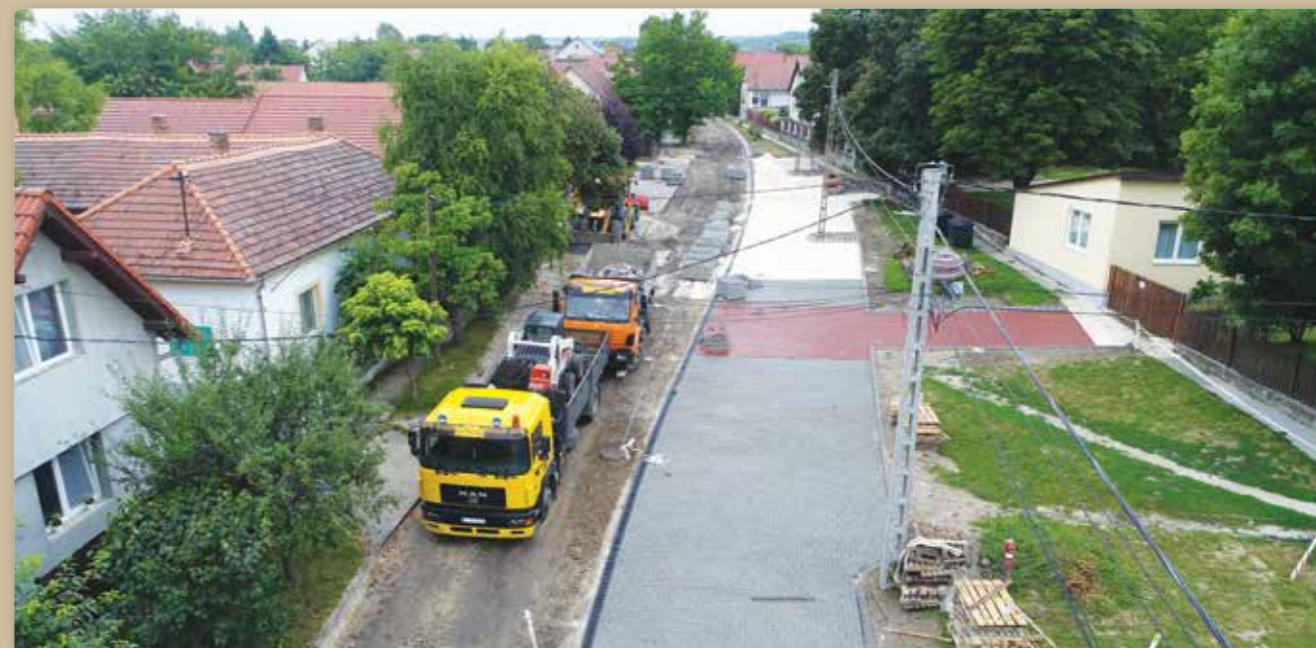
Készül a Szabadság utca óvoda és iskola közötti szakaszának felújítása
